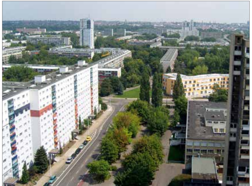
Abb. 1: Halle-Neustadt Am Tulpenbrunnen | Foto: P. Pasternack
